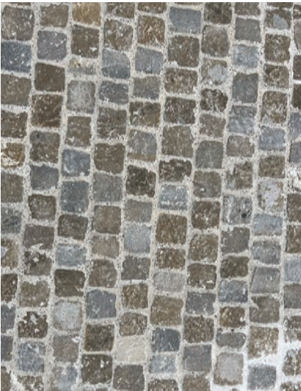
Mit Mörtel verfugte Pflasterung nach Tiefbau-Norm. Hier soll und wird nichts wachsen.
